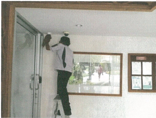
รูปภาพที่ 2.52 การตรวจสอบกล่องวงจรปิด
