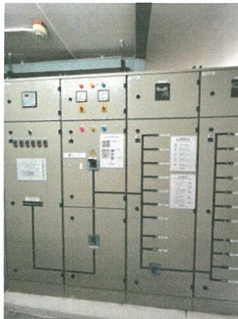
รูปภาพที่ 2.45 Capacitor Bank
