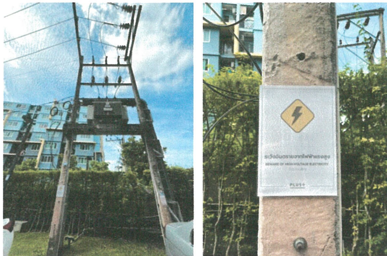
รูปภาพที่ 2.38 หม้อแปลงไฟฟ้า
